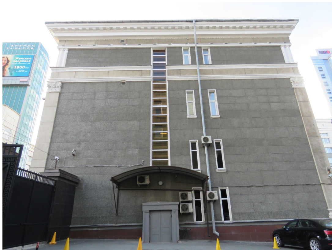
Рис. 7. Выявленный объект культурного наследия. Торцевой, восточный фасад
