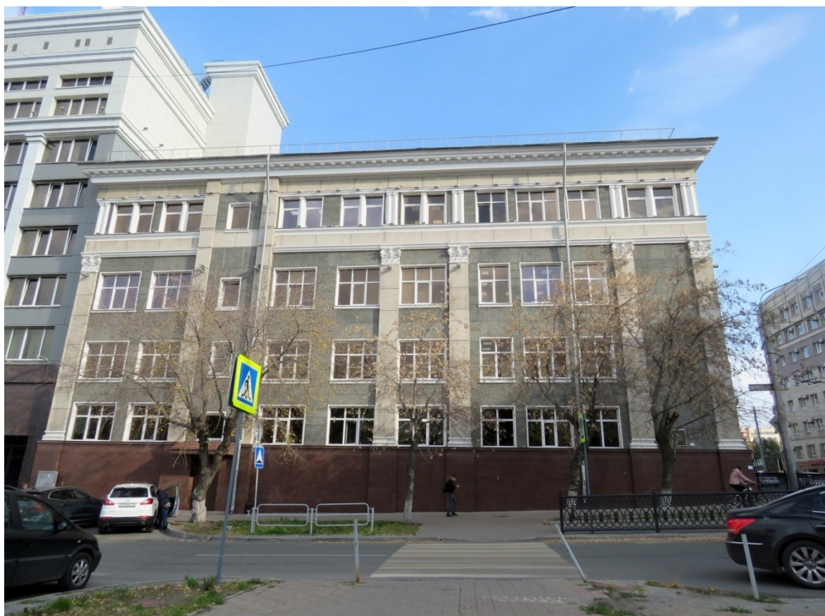
Рис. 5. Выявленный объект культурного наследия. Лицевой, западный фасад.
