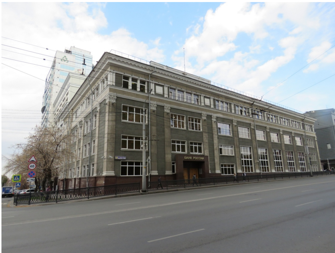
Рис. 3. Выявленный объект культурного наследия, вид с юго-запада. Лицевой южный фасад
