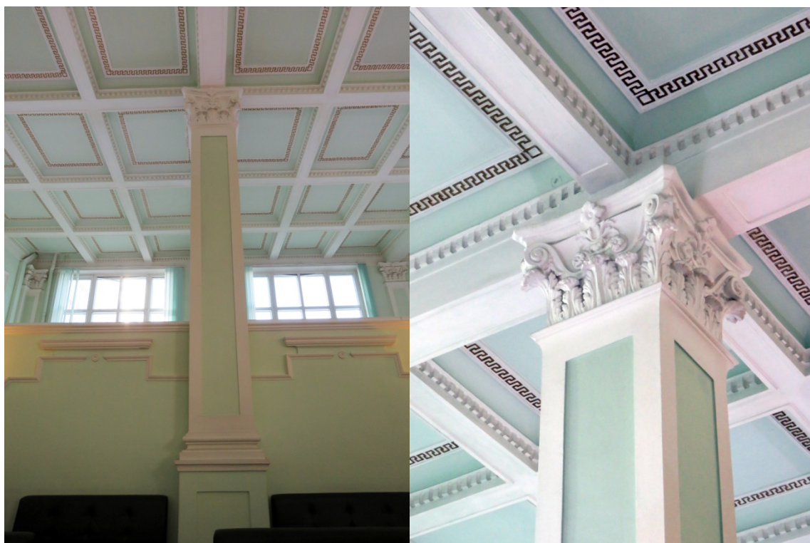
Рис. 14. Фрагмент архитектурного решения операционного зала. Колонна
