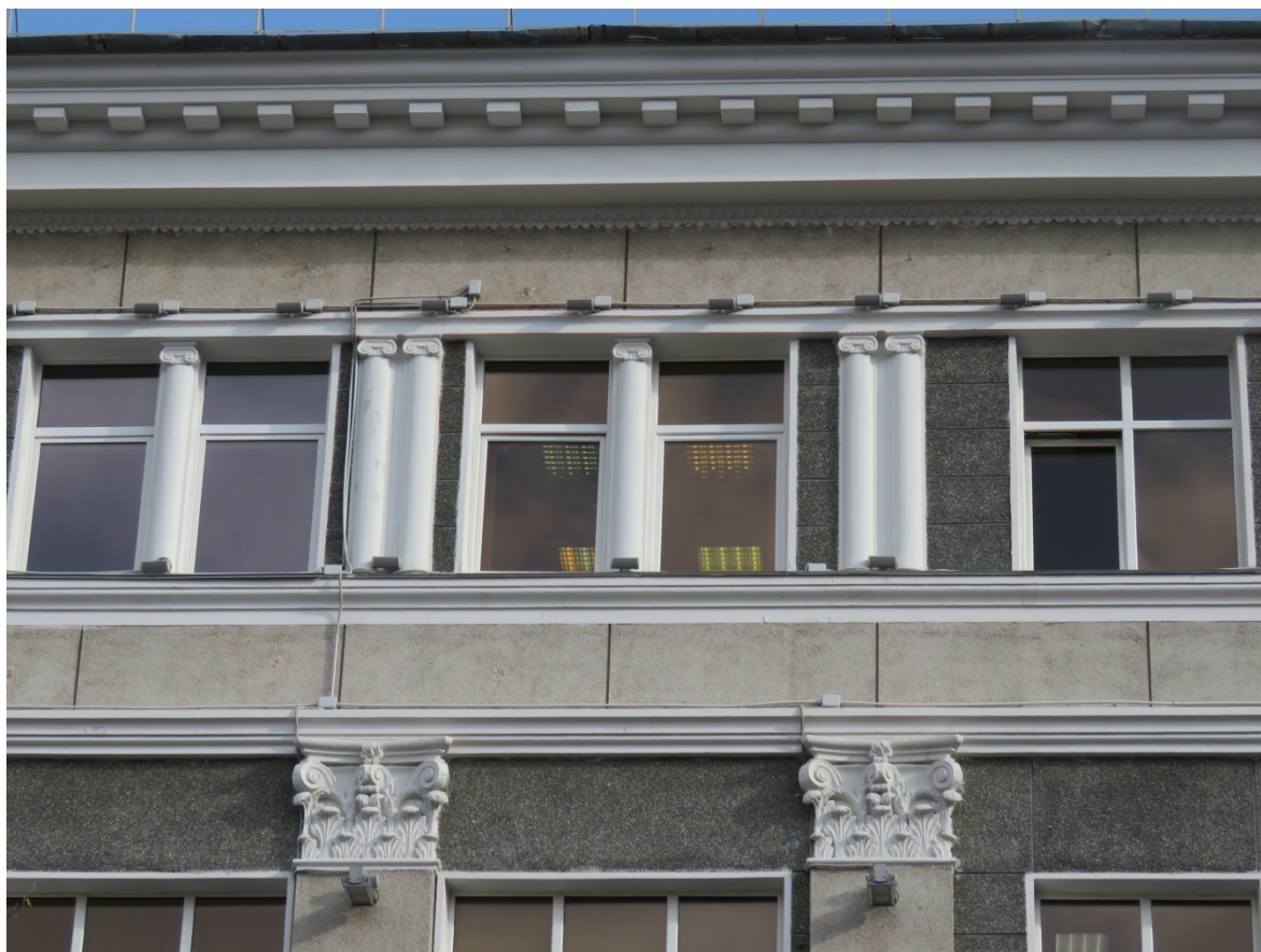
Рис. 6. Фрагмент западного фасада
