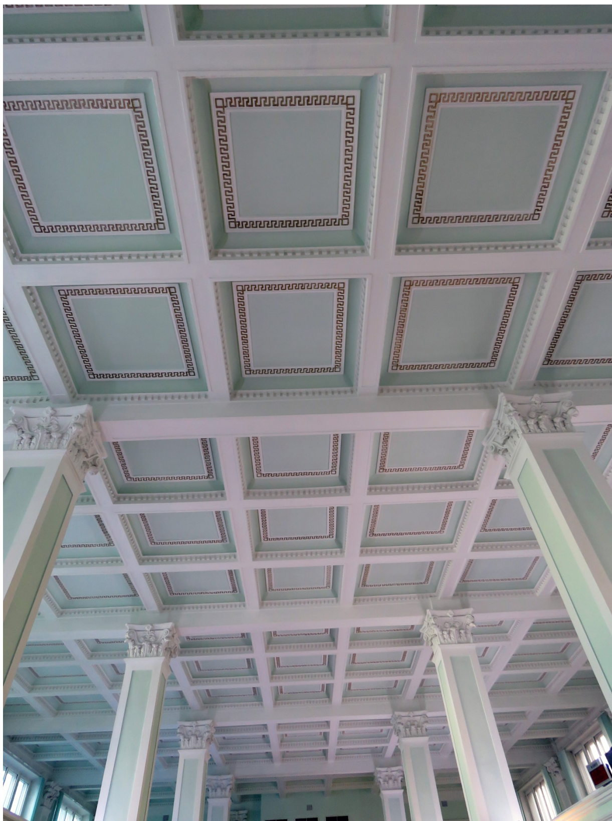
Рис. 17. Фрагмент архитектурного решения операционного зала. Кессонированный потолок
